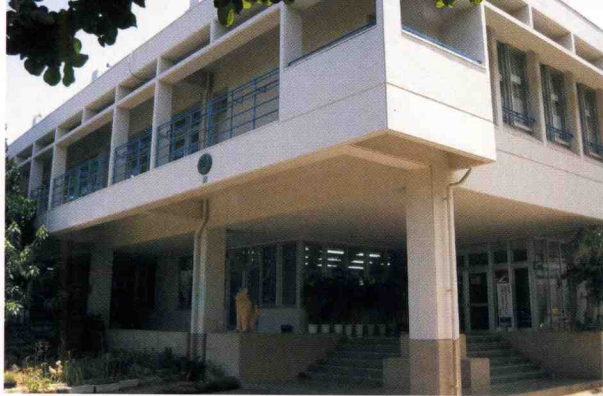
管理棟は1階に事務室や校長室、2階に音楽室や図書館などがあります。
